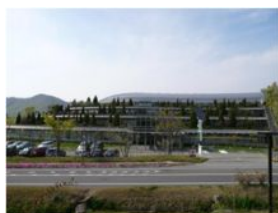
【テクノプラザ本館外観】
